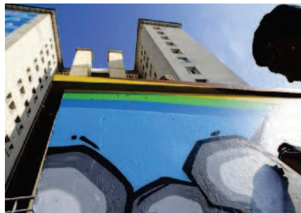
La rénovation urbaine de la Meinau prévoit plusieurs démolitions d'immeubles, dont celle du « 28 Normandie ».
